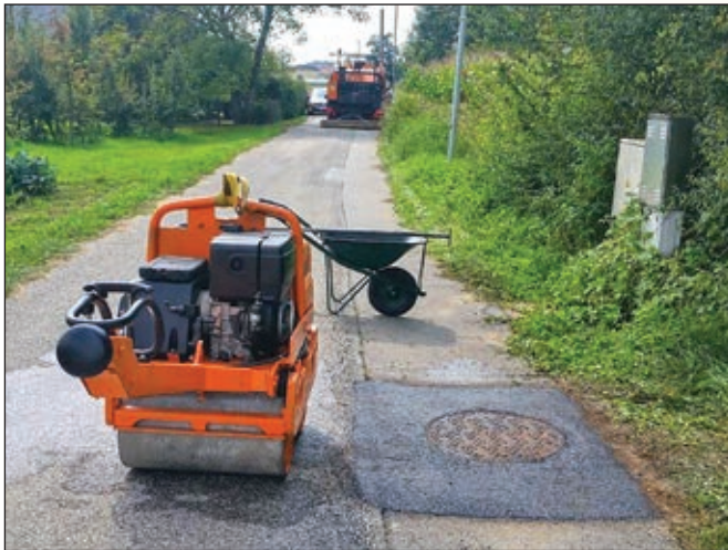
Sanacija kanalizacijskih pokrovov
