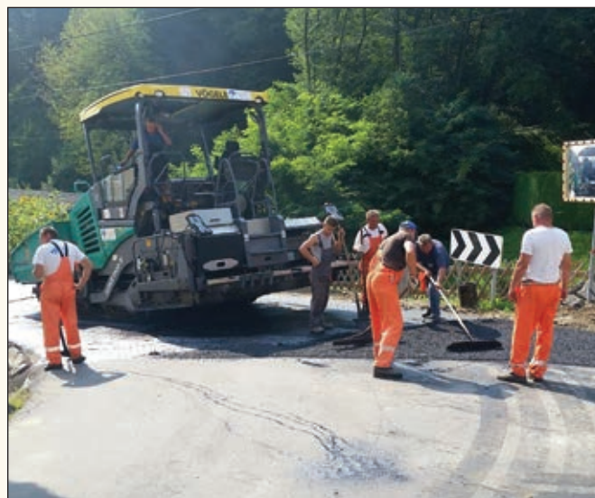
Obnova državne ceste skozi Fram
