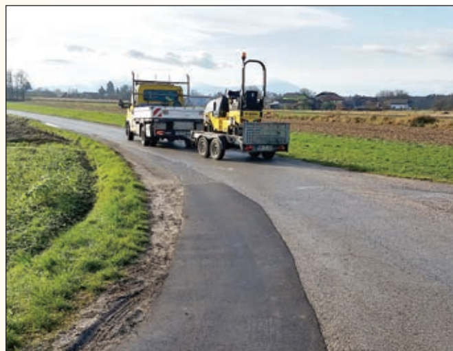
Krpanje asfaltnih površin na območju Rač
